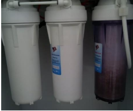
Hình 19: Hệ cột lọc tinh và trao đổi ion
